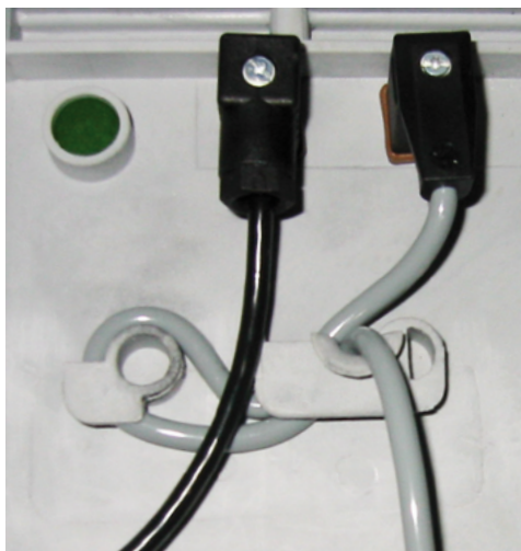
Verlegung des Handschalterkabels
